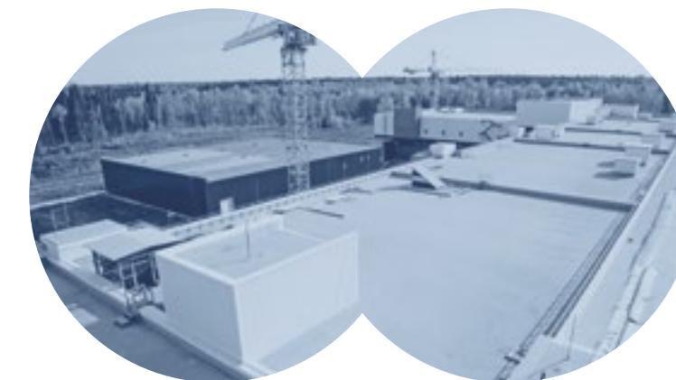
△ Строящееся здание модуля фабрикации ядерного топлива опытно-демонстрационного комплекса, создающегося на СХК в рамках проекта «Прорыв»
