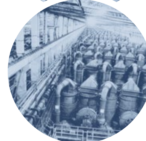
△ Газодиффузионное оборудование АЭХК
