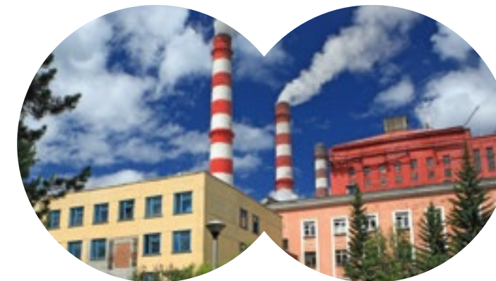
△ Теплоэлектростанция СХК была мощнейшей за Уралом
